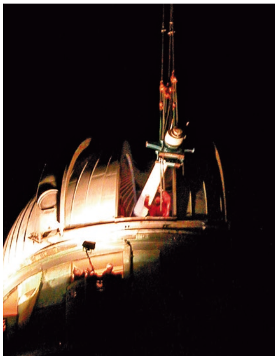
Das Teleskop-Rohr mit Okularauszug findet seinen Weg aus der Kuppel. Da die Uraniastrasse teilweise gesperrt werden musste, fand die Aktion in der Nacht statt.
