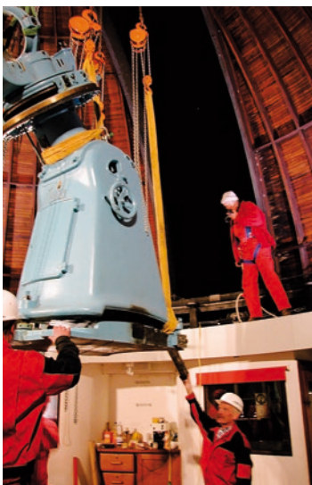
Der Montierungsblock, etwa sieben Tonnen schwer, wird aus der Kuppel gehievt.
